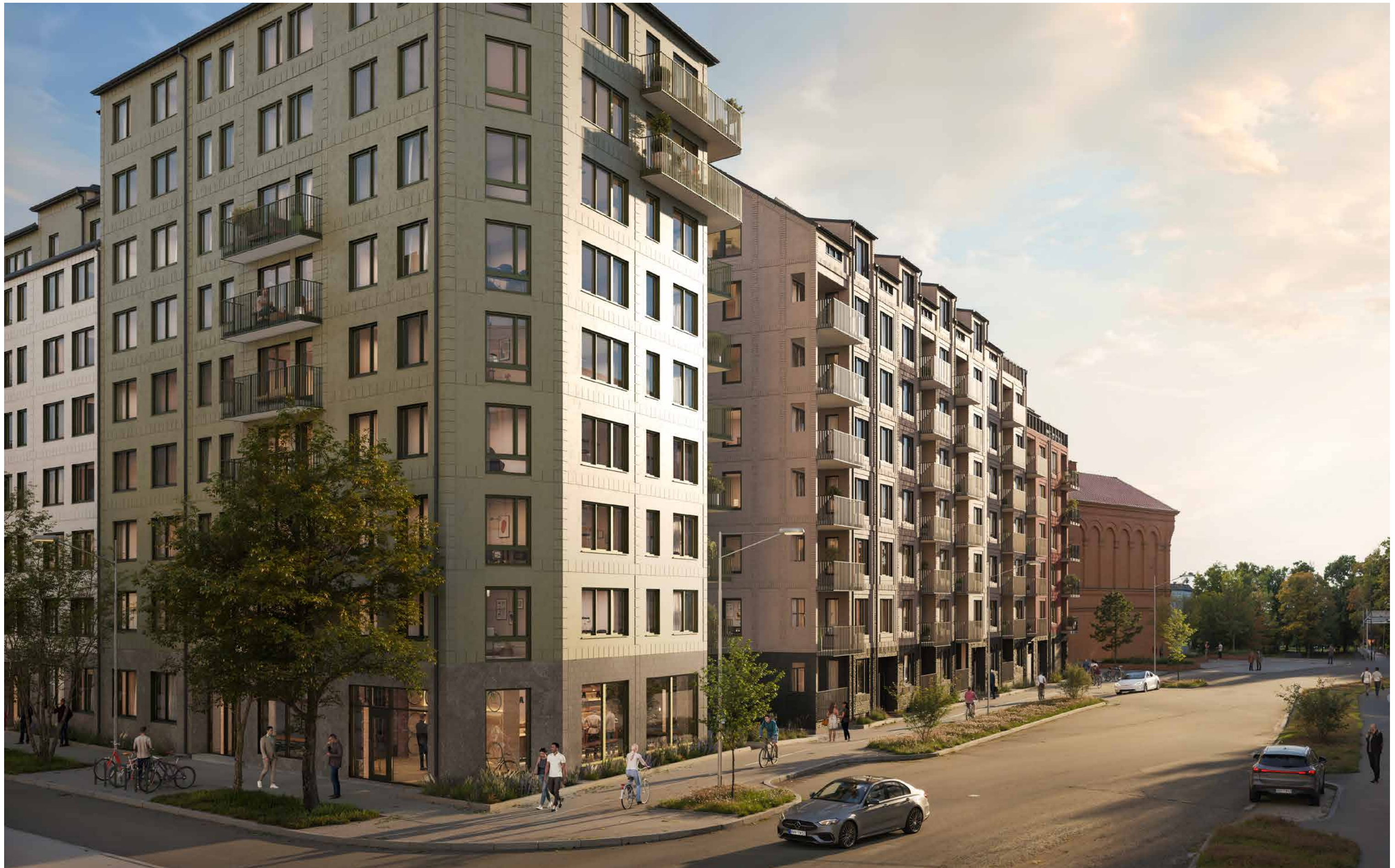
Vid planerandet av Skeppskajen har stor vikt lagts vid att husen ska ha olika karaktär och höjd. De olika husen rymmer allt från mindre lägenheter med välplanerade ytor till generösa hem med stort utrymme och öppna planlösningar.
